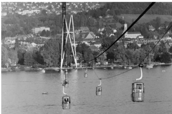
Abbildung 7: G59-Gondelbahn, Zürich (Ermel 2016)
