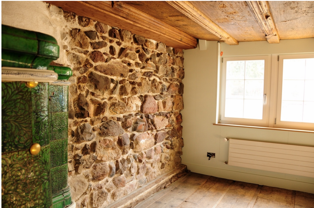
Abb. 14: Wohnzimmer mit Kachelofen, Bollensteinmauer mit Brandspuren und verzierter, gotischer Decke.
