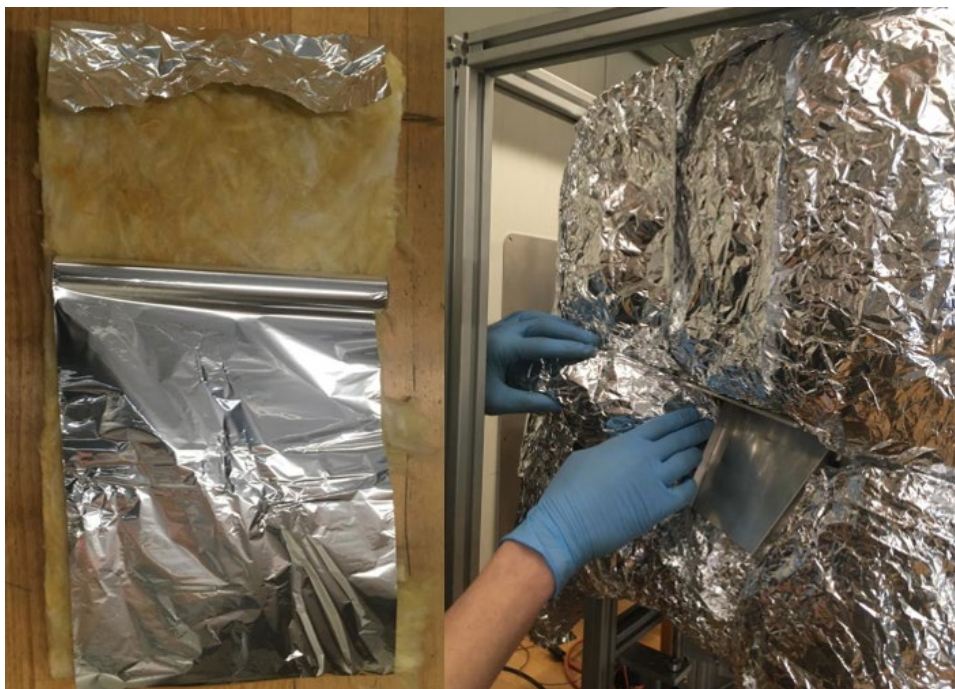
Abbildung 6-20: Einpacken und anbringen der Isolation
