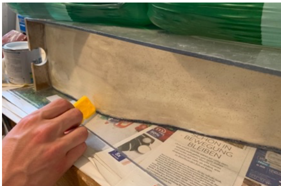
Abbildung 13: Entfernung von überschüssigem Silikon durch Fugenglätter
